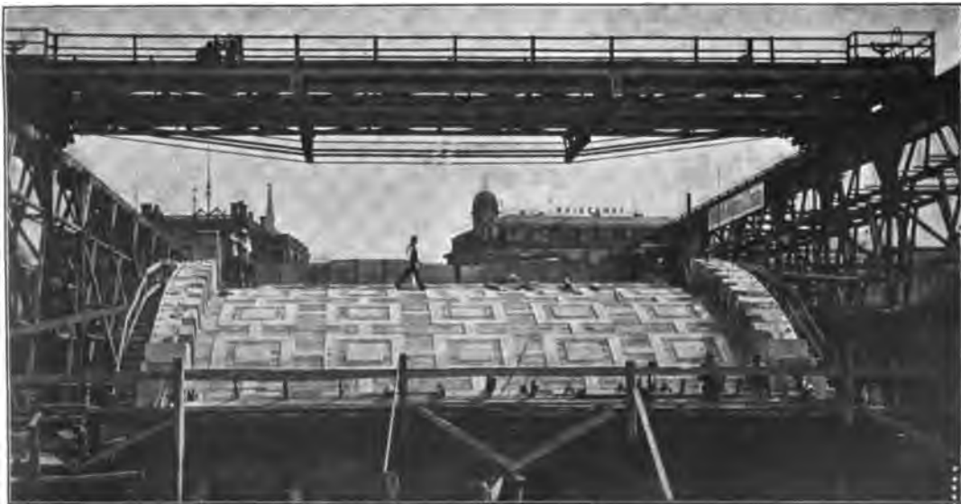
Abb. 62. Schalung für die Bögen der neuen Augustusbrücke in Dresden.
